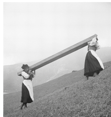
Albert Nyfeler, Transport du bois pour la construction du chalet de Hans Lehner, Lauchernalp, 1936. © Albert Nyfeler, Médiathèque Valais – Martigny
